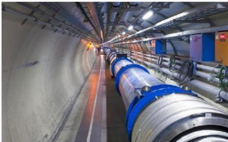
À l'intérieur du tunnel, 9600 électro-aimants entourent le tube à vide où circulent les protons
