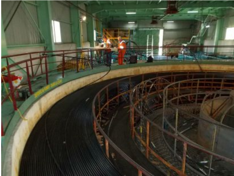
Câble principal en cours de test et stockage à La Seyne/Mer
