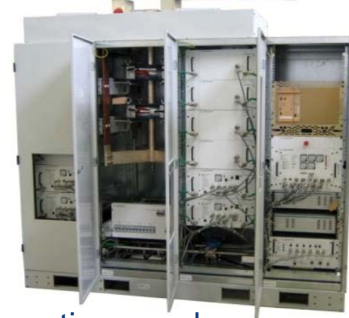
Convertisseurs de puissance: précision 1ppm
