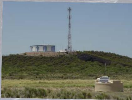
Observatoire Pierre Auger. Sur la colline : un des bâtiments abritant 6 des 27 télescopes de fluorescence. Au premier plan, un des 1660 détecteurs de particules © Pierre Auger Observatory
