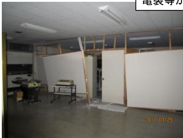
2階制御室外壁落下
