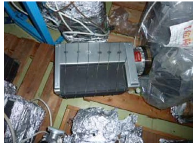
立てて保管してあったイオンポンプが転倒
