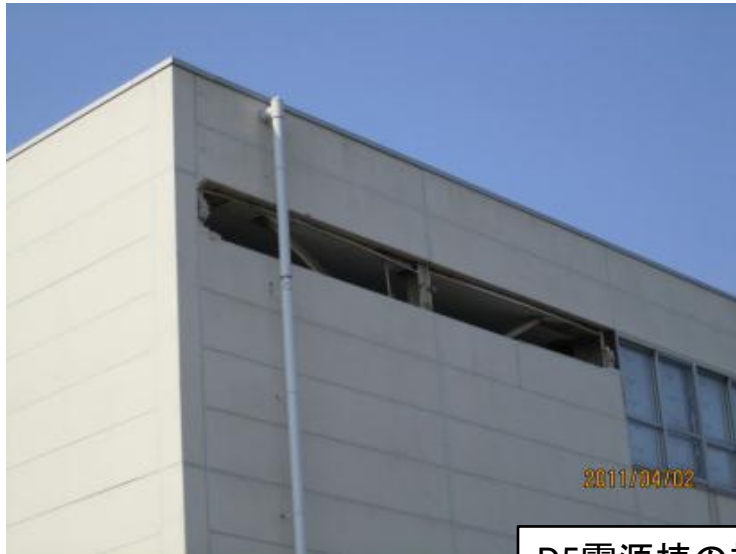
2階制御室外壁落下
