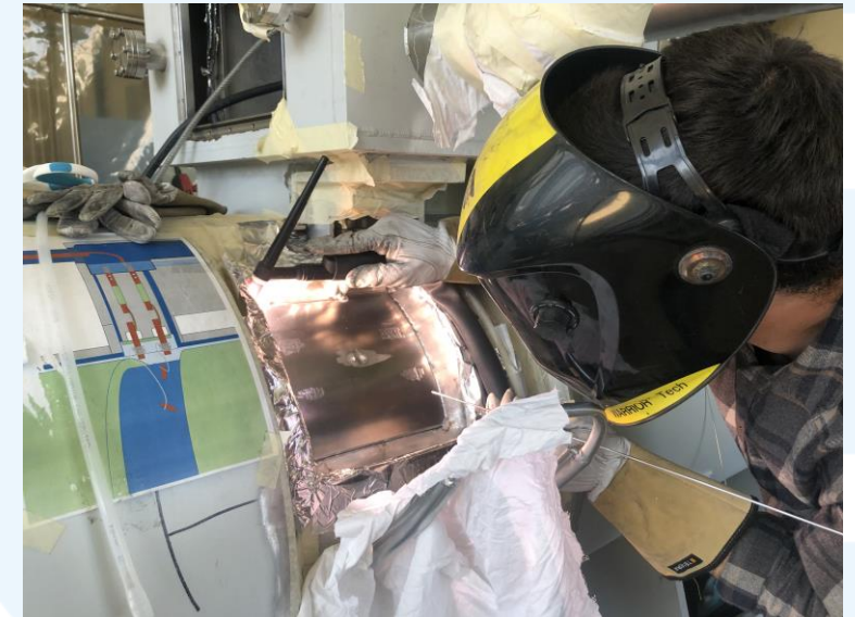
Opération de soudage
