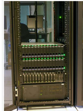
La baie de stockage
