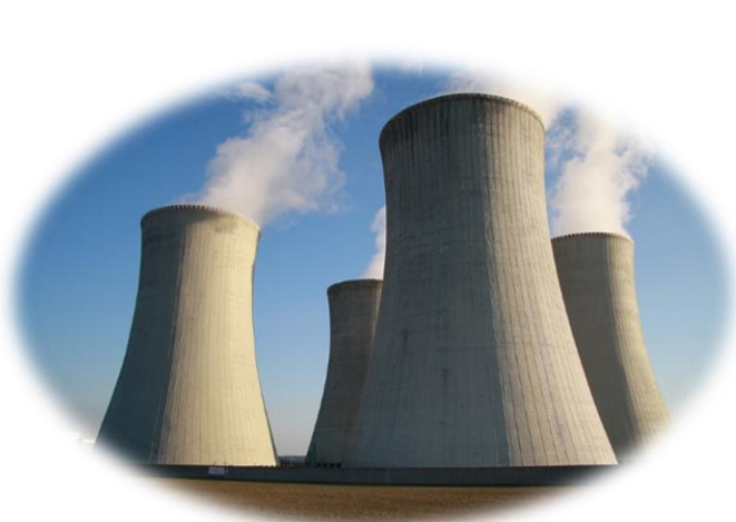
Dukovany Nuclear Power Plant cooling towers, 2013 — Jiří Sedláček / Wikimedia Commons (CC BY-SA 4.0)
