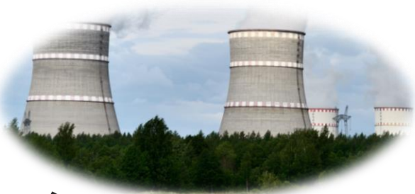
Kalinin Nuclear Power Plant, 2025 — Vsatinet / Wikimedia Commons (CC BY-SA 4.0)
