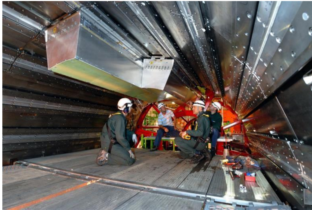
Installation des modules un par un
