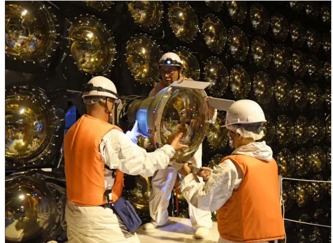
Installation manuelle des photomultiplicateurs
