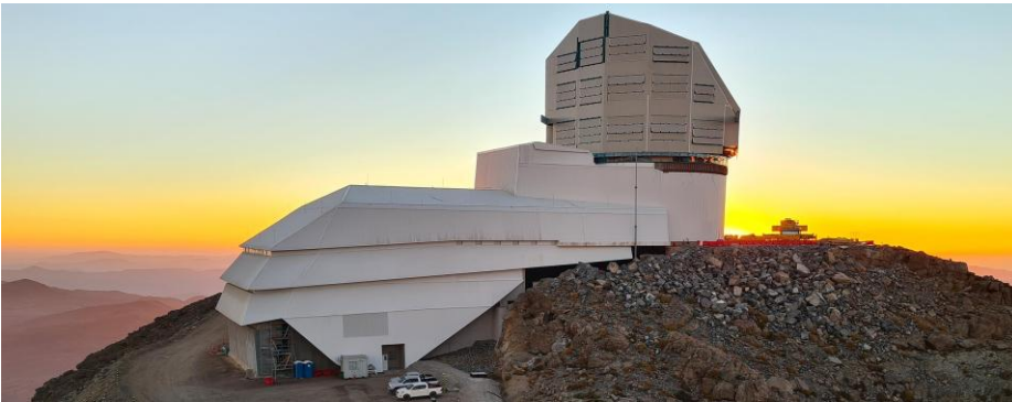
Infrastructure du télescope LSST
