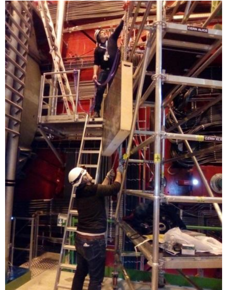
Démontage de quadrants d'ALICE
