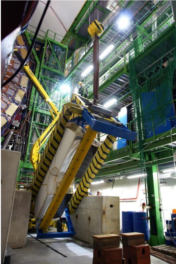
Mise en position verticale
