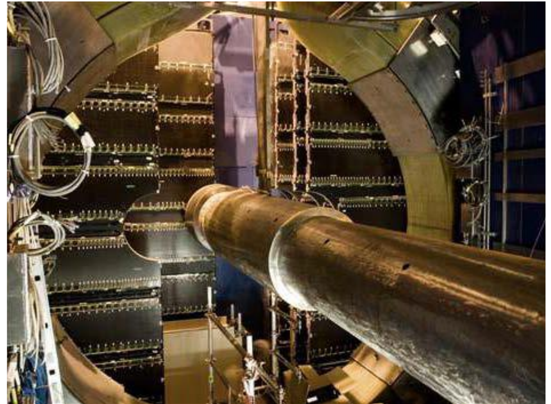
Installation des stations une par une
