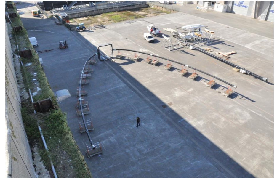
Montage à blanc de l'arche
