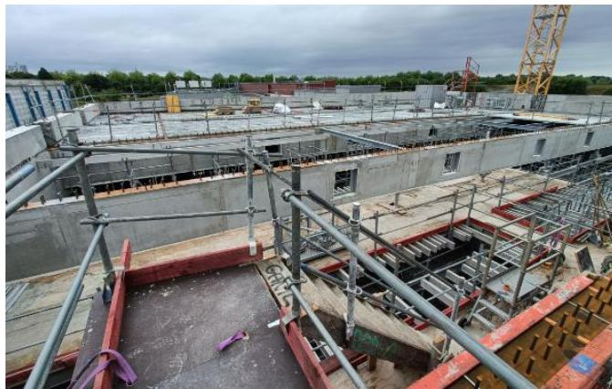
**2024 : Voiles et couverture du hall puis coulée dalle béton lourd zone spectromètre HRS**
