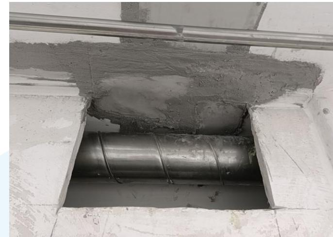
Sortie de secours S3 : remontée d'eau au niveau du joins de dilatation et infiltration notable inter-dalles supérieure
