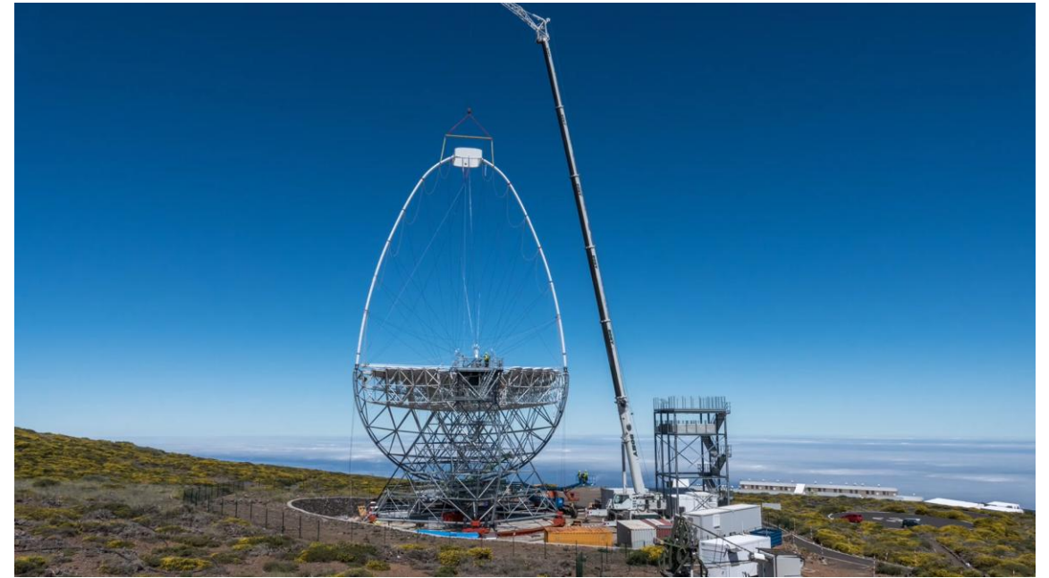
Fixation définitive des haubans à la nacelle, en accéléré
