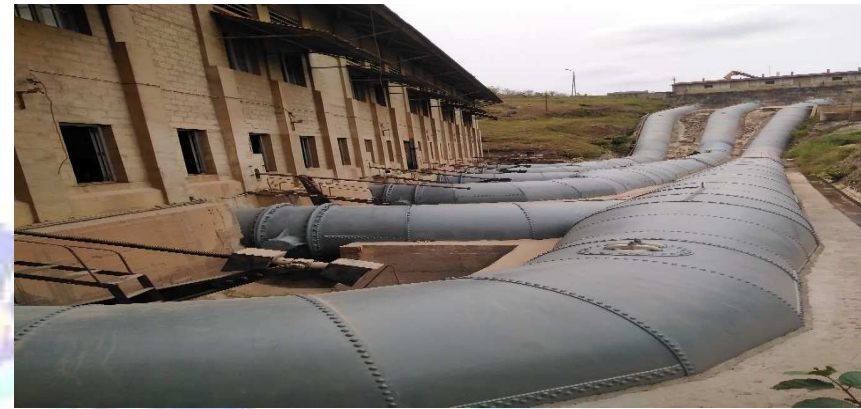
Ressuage et ultrasons des conduites forcées du barrage de SANGA
