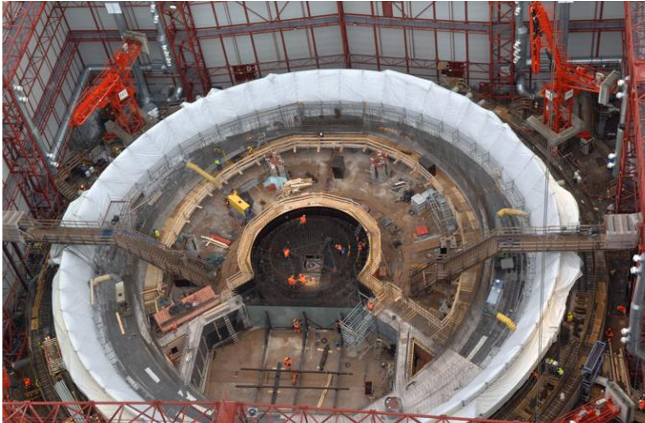
Construction du réacteur EPR à Olkiluoto (Finlande). Mars 2007. Copyright AREVA/P. Bourdon.
