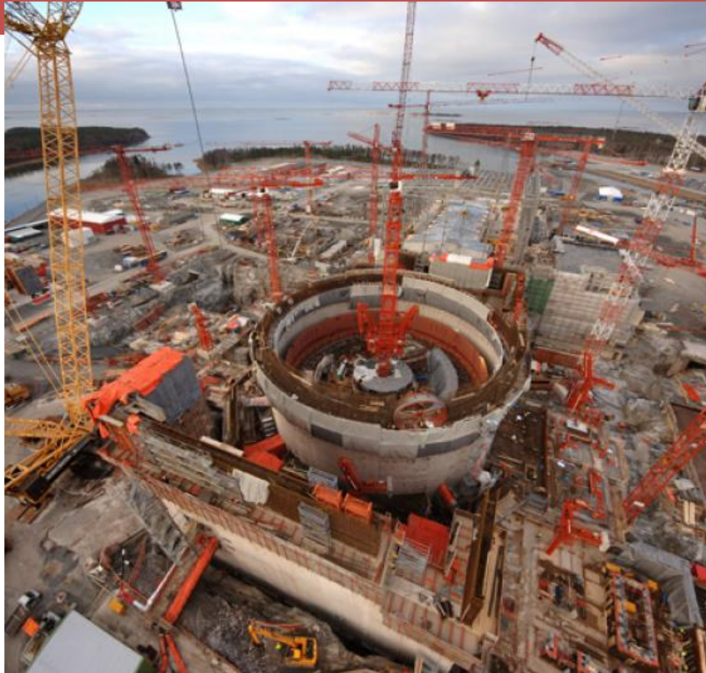
Construction du réacteur EPR sur le site d'Olkiluoto (Finlande), janvier 2008. Copyright AREVA/Bourdon Paivi.
