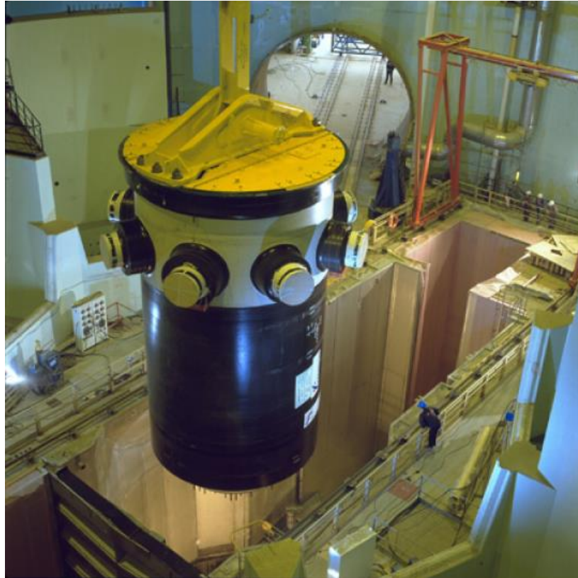
Mise en place de la cuve du réacteur 1 de la centrale nucléaire de Civaux (France). Copyright AREVA/L. Godart.
