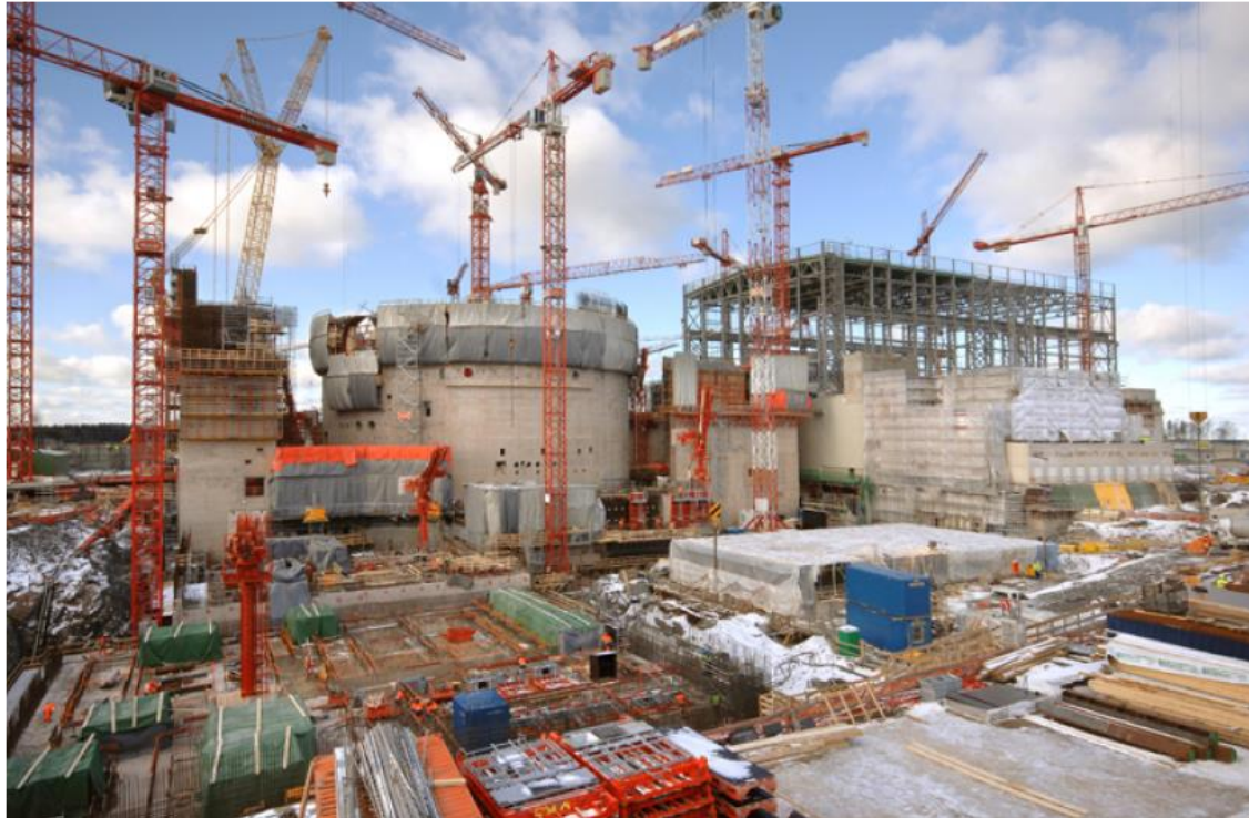
Construction du réacteur EPR sur le site d'Olkiluoto (Finlande), mars 2008. Copyright AREVA/Bourdon Paivi.
