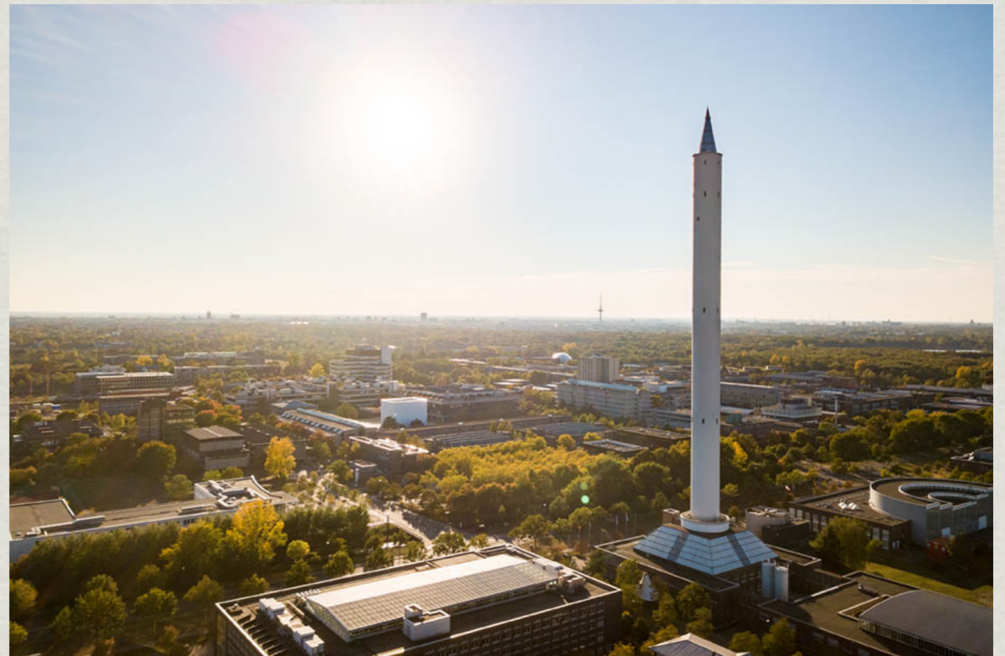
LA TOUR DE CHUTE LIBRE DU ZARM (BRÊME): 146M POUR 4.7S DE MICRO-GRAVITÉ
