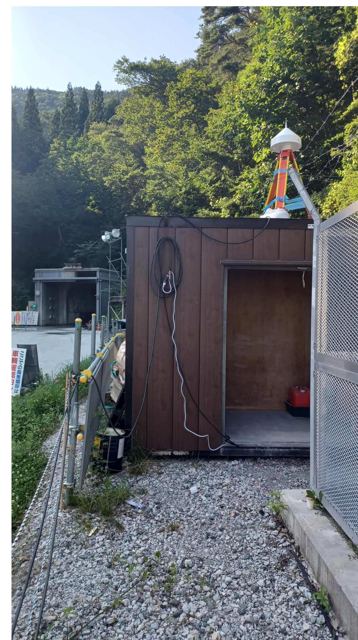
Figure 6 – Photo de l'entrée de la caverne du détecteur lointain d'Hyper-Kamiokande et de l'installation temporaire de l'antenne GNSS durant l'été 2023.
