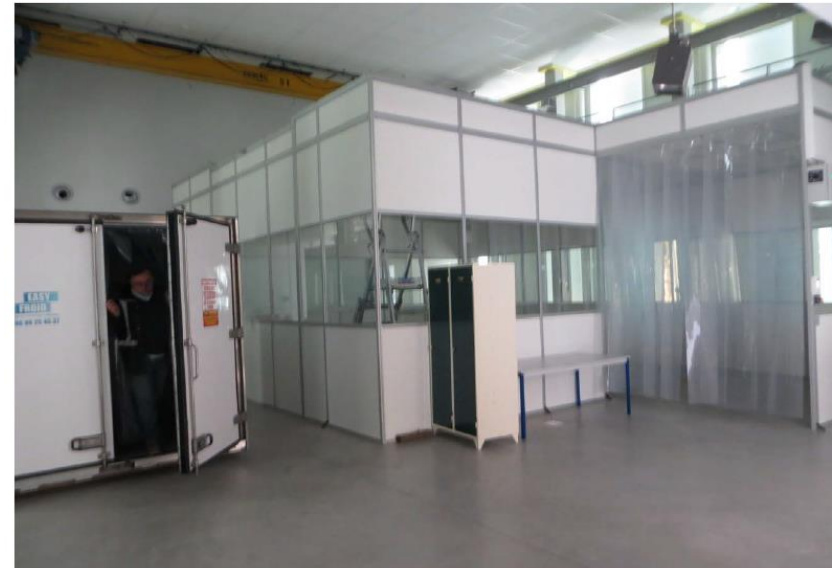
Salle blanche + caisson froid (-15°C à 20°)
