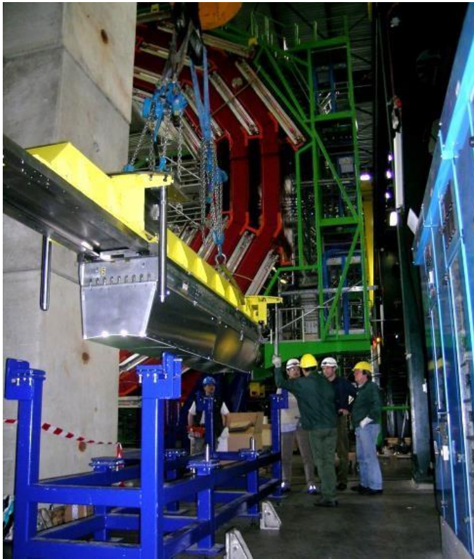
Mise en position des modules sur le rail
