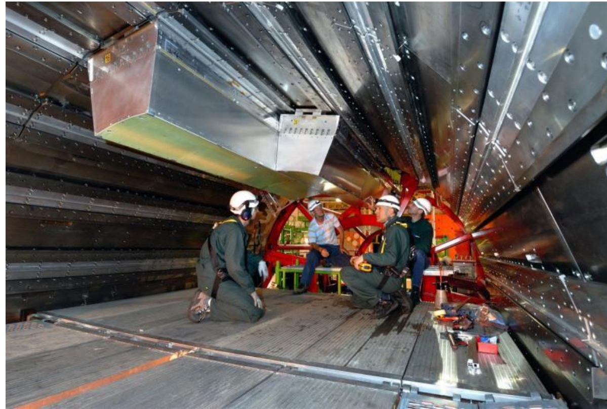
Installation des modules un par un
