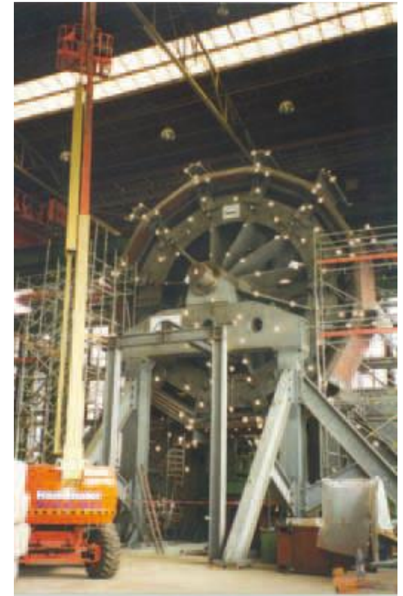
Contrôle en usine de structure de grande dimension
