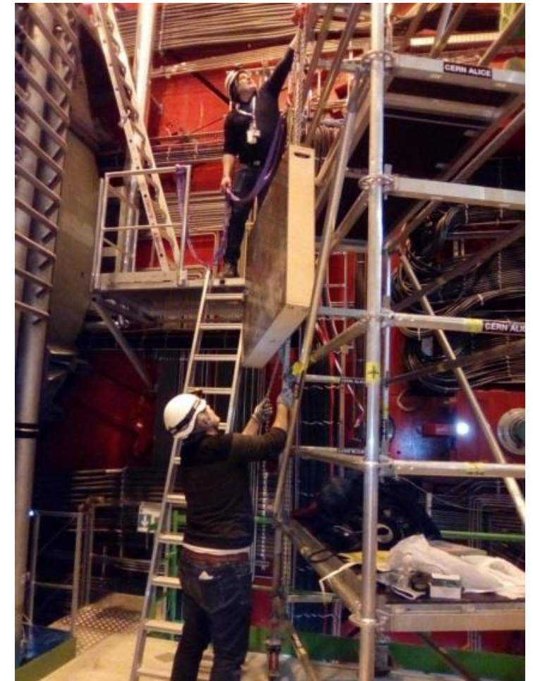
Démontage de quadrants d'ALICE
