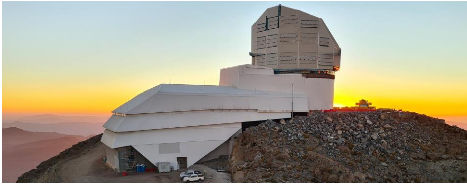
Infrastructure du télescope LSST
