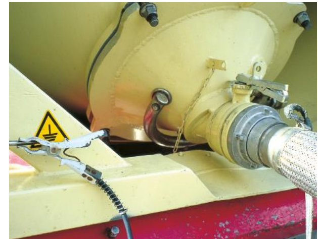
Mise à la terre d'une citerne
