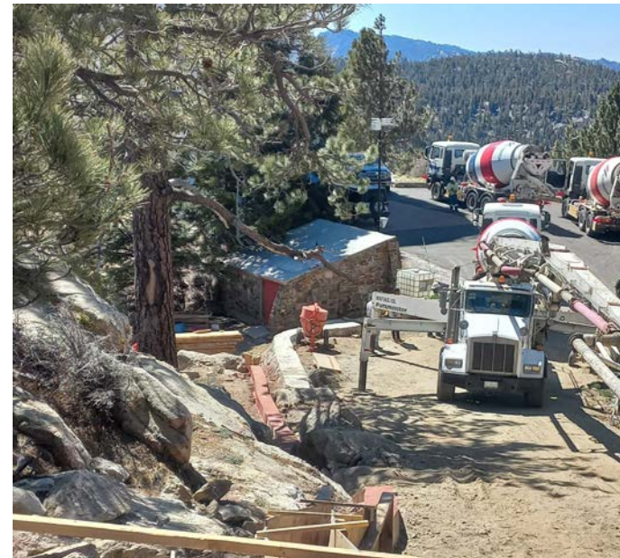
Foundation last pouring @ OAN
