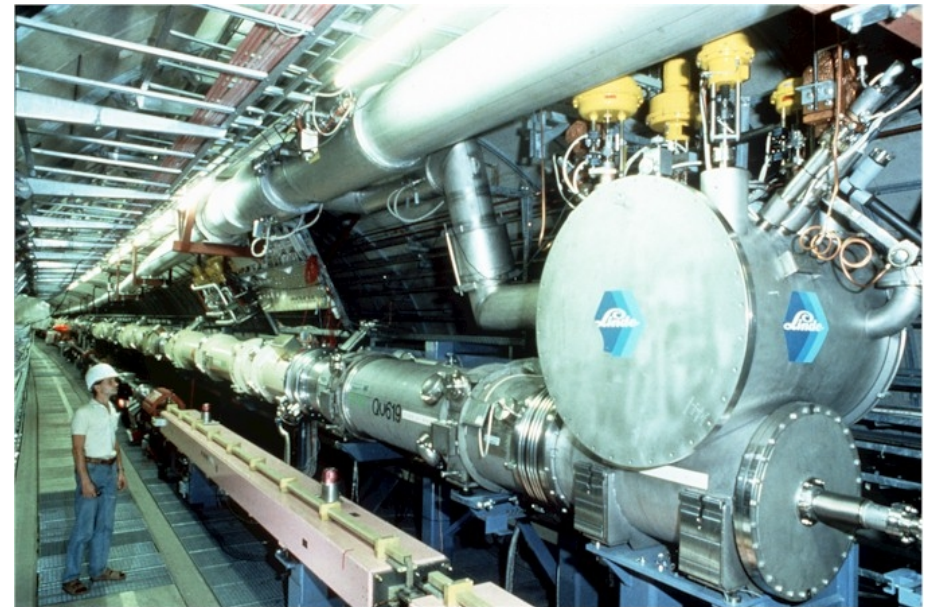
Dans le tunnel de HERA
