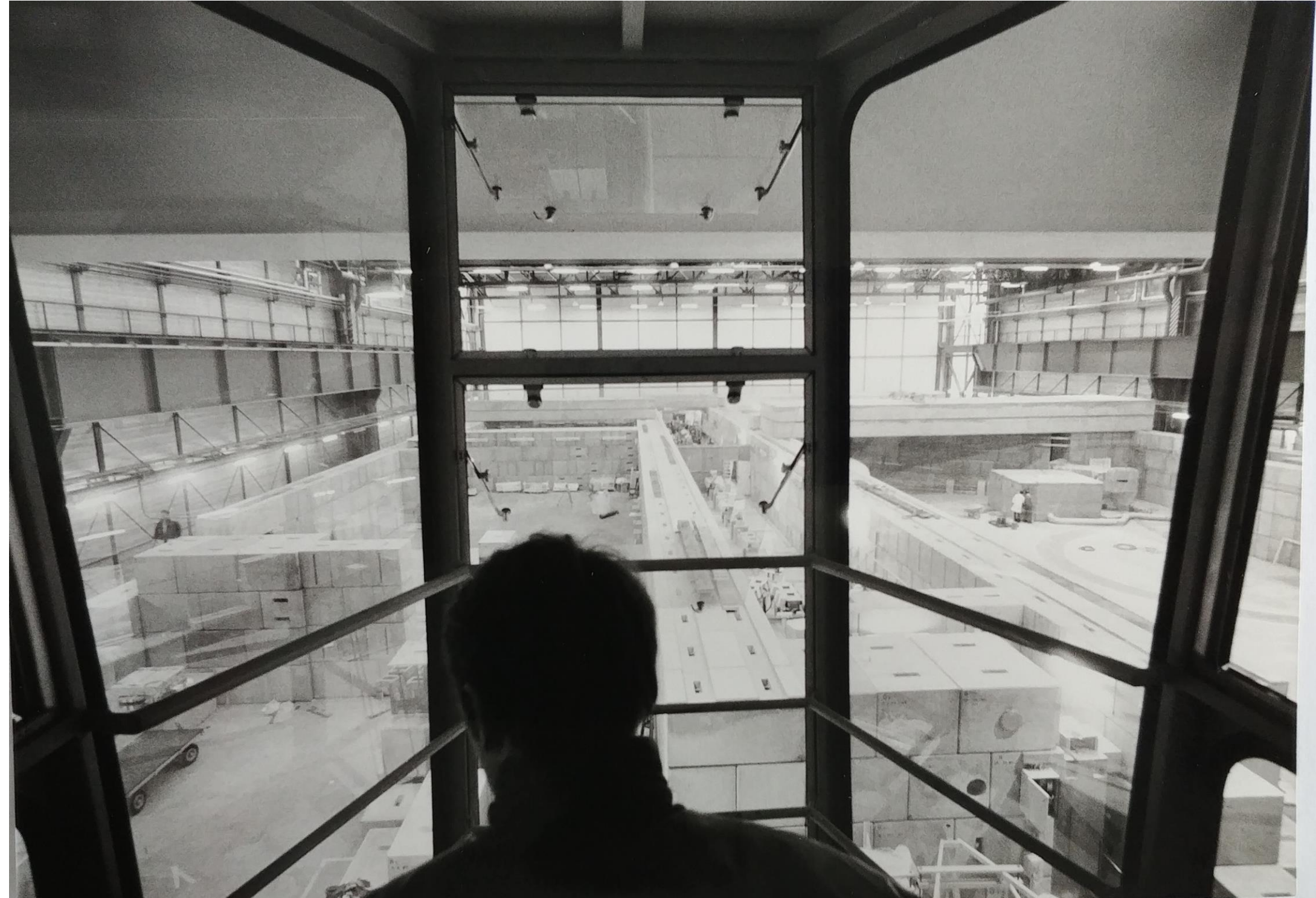
Montage du pont roulant, aires des expériences, vers 1982, ©CNRS Photos (Photothèque de Meudon)
