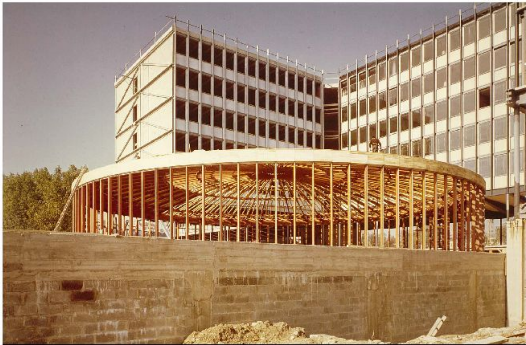
Construction du CCPN sur l'ancien site de la Halle aux Vins, sur le campus de Jussieu (à Paris). © CC-IN2P3
