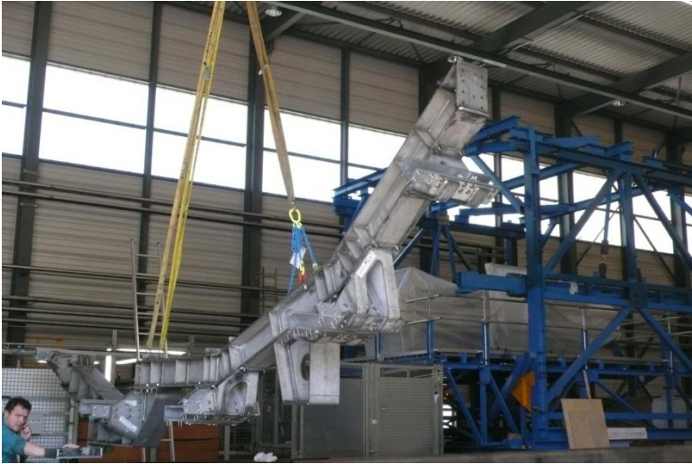
Démontage du site du test de charge
