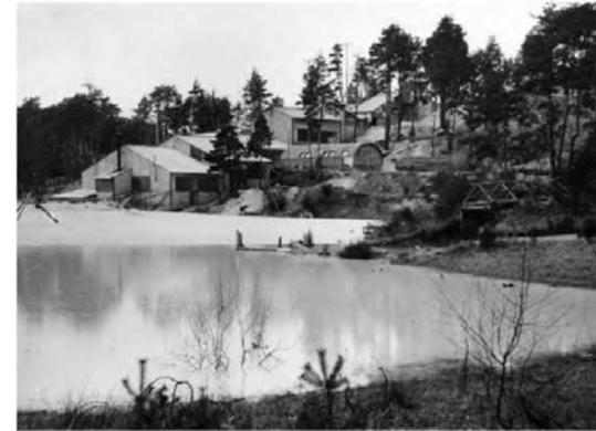
Vue générale de la laverie mécanique de Rophin en 1953 (photo CEA)
