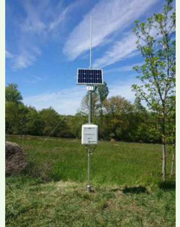
Déploiement sur site pilote (Auzon) Passerelle Multitech Version outdoor Communication GSM
