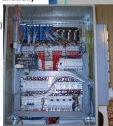
Armoire Électrique de commande
