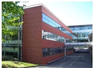
Institut de Physique et Chimie des Matériaux de Strasbourg
