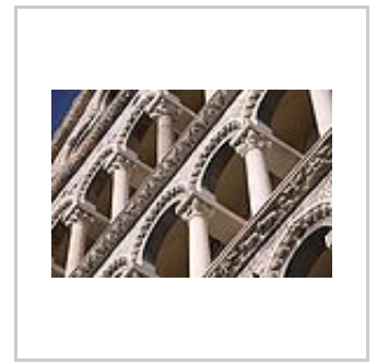
Détail des galeries de la façade.
