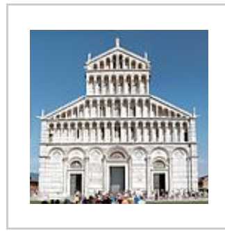
La façade, tout en marbre finement marqueté. Agrandir la photo pour voir les détails.
