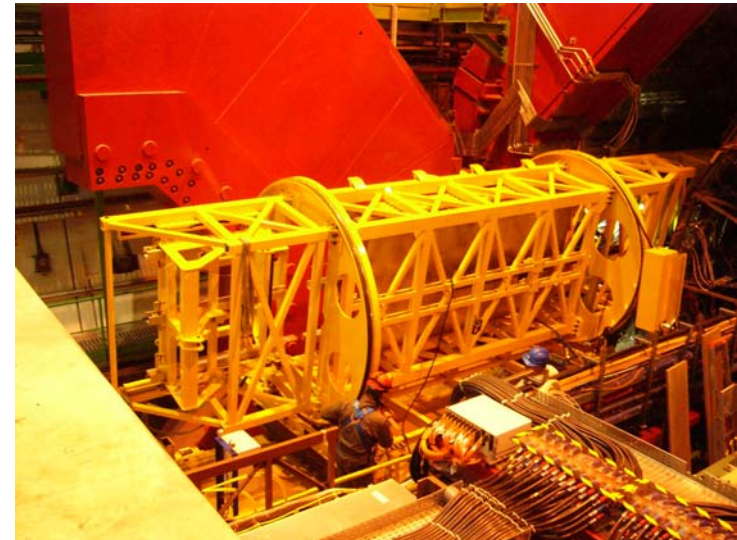
13. Insertion du SM dans la StructureSupport
