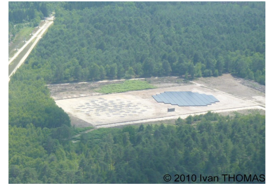
La station LOFAR de Nançay – 192 antennes
