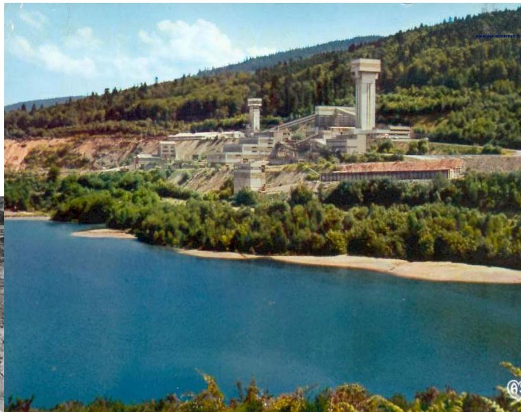
*Vue aérienne du site. Au premier plan, le champ d'épandage des résidus de traitement de Lavaugrasse. A gauche, l'embranchement ferré utilisé pour la réception des minerais «privés» et les installations CEA de l'atelier de préparation des minerais. A droite, l'usine SIMO.*
