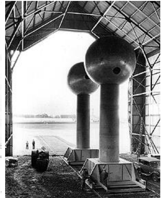
Construction dans un ancien hangar de dirigeable
