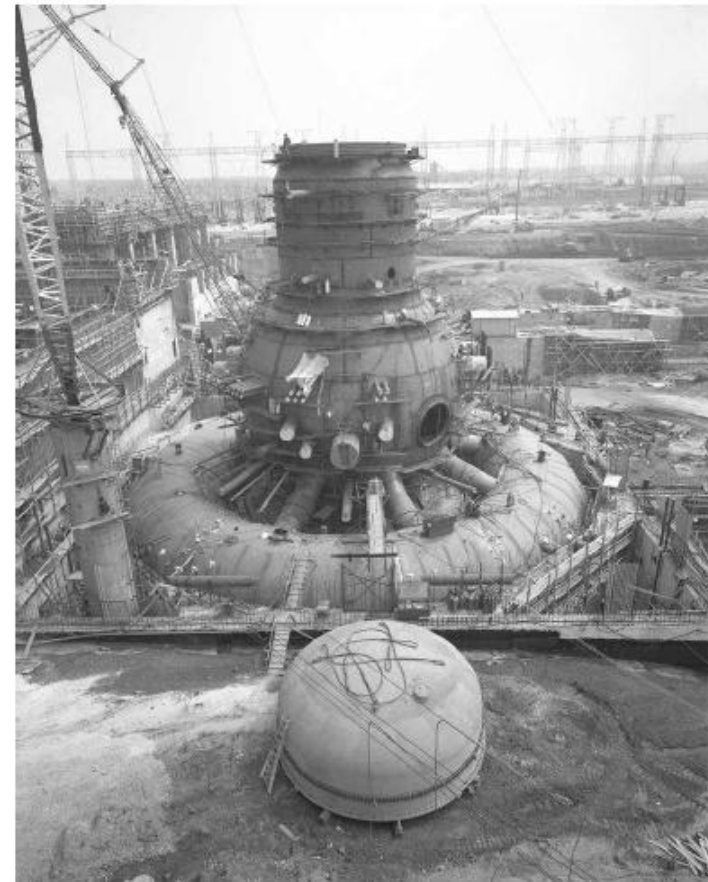
L'enceinte de confinement
