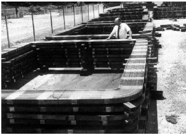
Bobinage en argent de la réserve fédérale US
