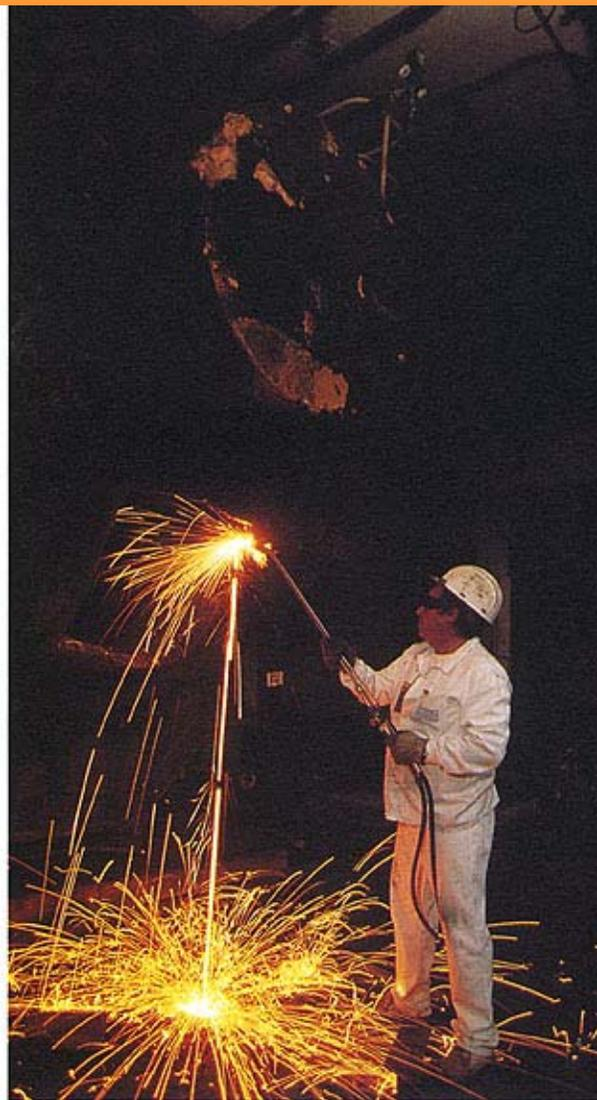
Démantèlement du réacteur G2 : opération de découpe et cisailage.
